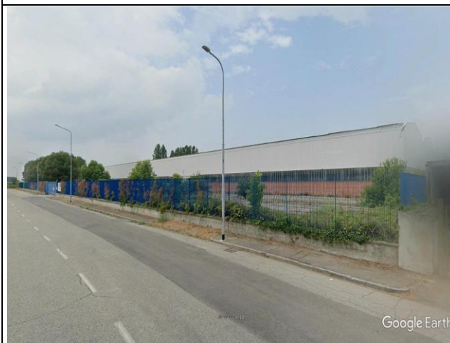
Vista su strada antica Morano prima della demolizione capannoni
