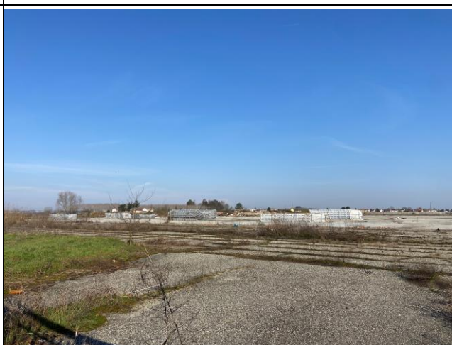
Vista su strada Morano dopo la demolizione capannoni
