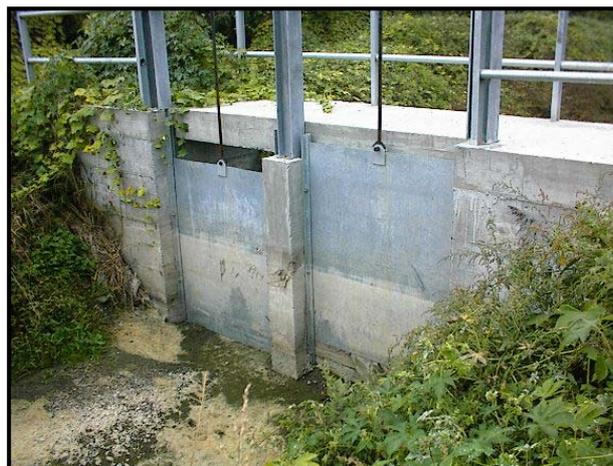
Foto 2 – Vista da monte delle paratoie d'intercettazione, lungo l'alveo della roggia.
