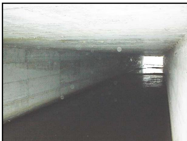
Foto 3 – Vista da monte del tratto coperto, costituito da uno scatolare rettangolare in cemento.
