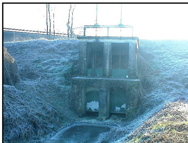
Foto 2 – Vista da monte delle paratoie d'intercettazione, lungo l'argine del Po.
