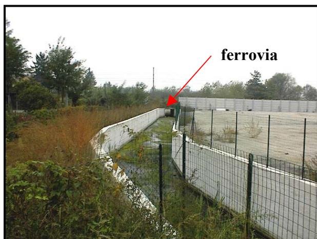
Foto 1 – Tratto a monte dell'attraversamento ferroviario, costituito da uno scatolare in cemento.
