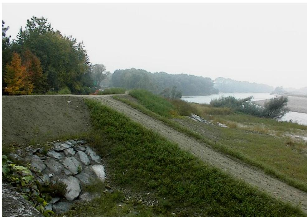
**Figura 11 - Realizzazione della difesa spondale destra a monte del ponte stradale.**
